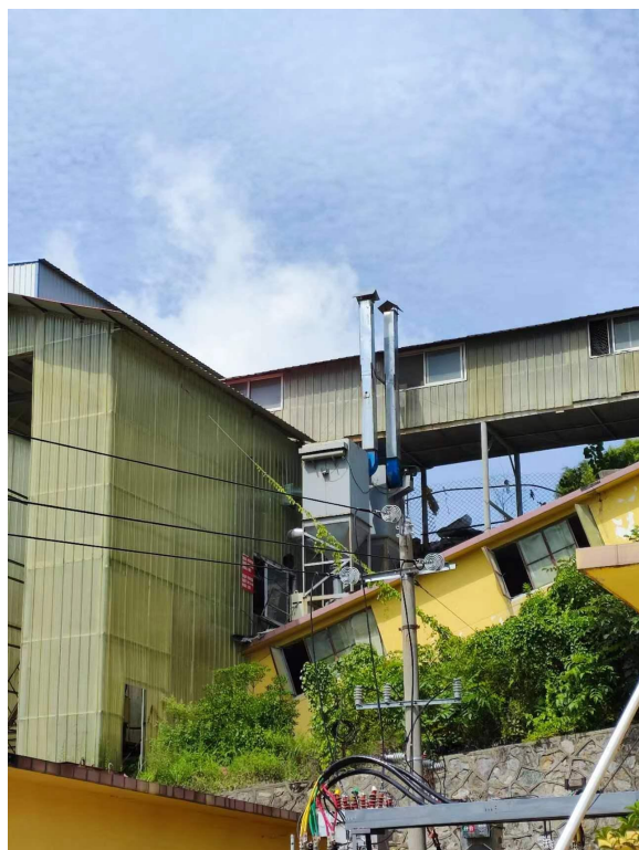
细破除尘器 (DA002、DA003)
