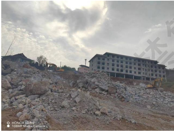
西侧正在建设的养老服务中心
